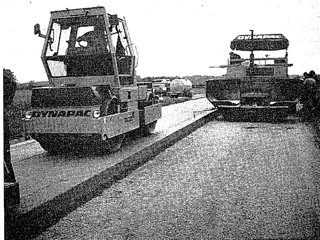
Utläggning av vältbetong
